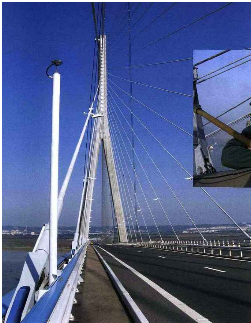
A gauche, un des quatre récepteurs bifrédence GNSS installés sur le tablier du pont de Normandie. Ci-dessus, Serge Garrigou au sommet.
